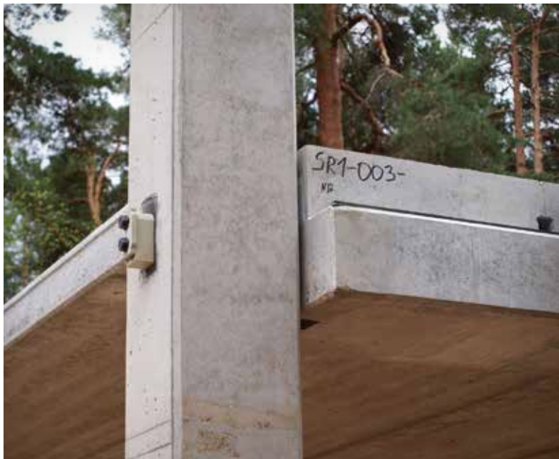
Raccordement d'une colonne préfabriquée et d'une poutre en té inversée avec une dalle alvéolaire — vue isométrique
